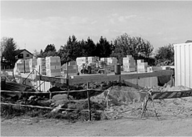
Die Baustelle am 02.05.1990 (Foto: Smlg. W. Klingelschmitt)
