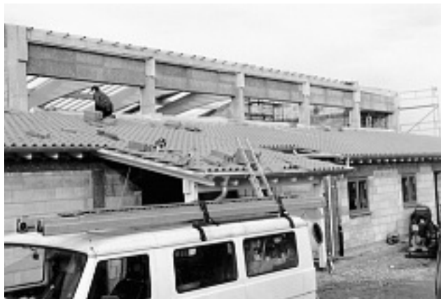
Der Rohbau der Mehrzweckhalle 1993 (Foto: Smlg. Grundschule Siefersheim)
