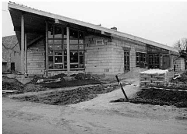
Der Rohbau am 09.12.1990 (Foto: Smlg. W. Klingelschmitt)
