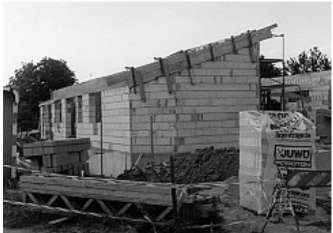
Die Baustelle am 30.05.1990 (Foto: Smlg. W. Klingelschmitt)
