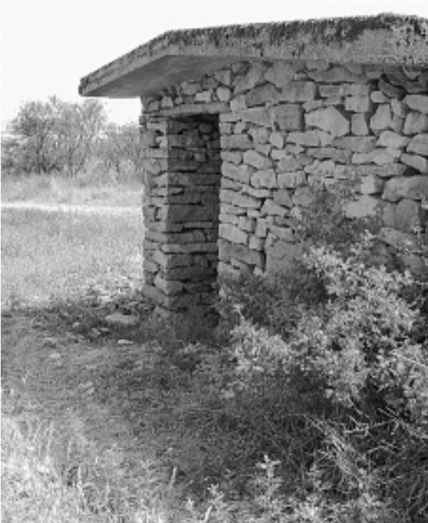
Weinbergshaus in Trockenmauertechnik mit Betondach auf der Höll (Foto: A. und B. Hoffmann)
