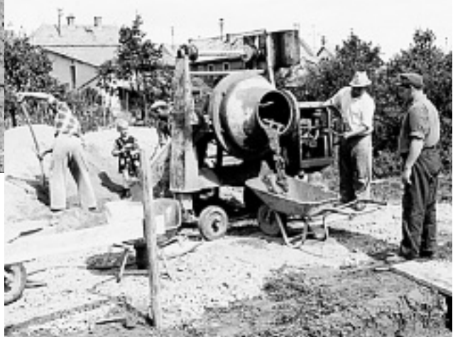
Bauarbeiten für die neue Schule (Foto: Smlg. M. Flessa)
