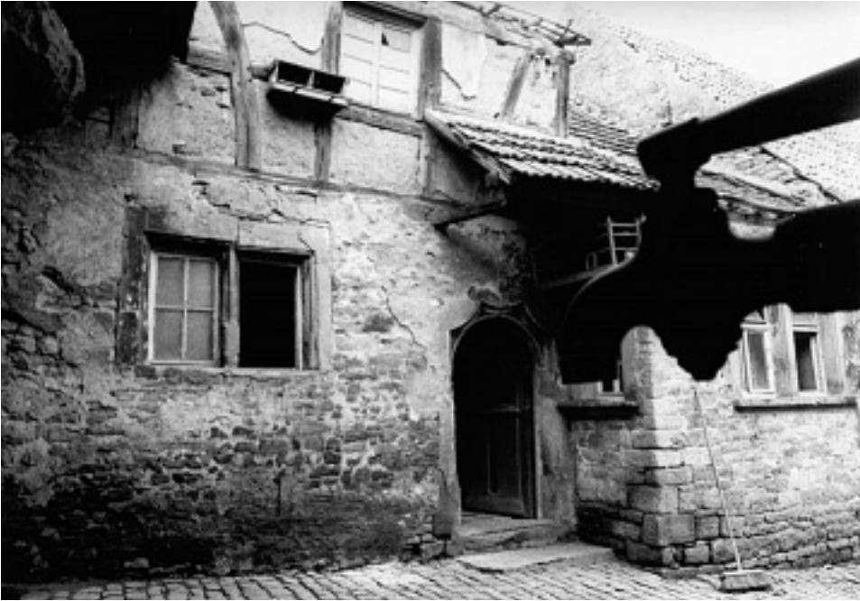
Wohnhaus mit Haustüre und Zwillingsfenster, 16. Jahrhundert (Rheinl.-Pfälz. Freilichtmuseum Bad Sobernheim, K. Wiechert, 1981)
