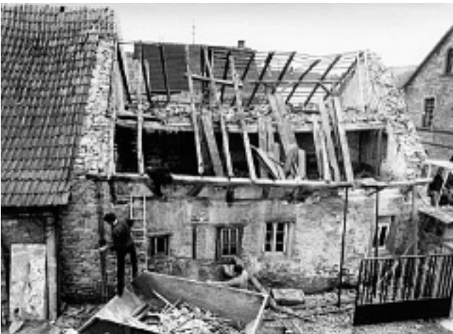
Abbau des Hauses aus der Hintergasse 4 gesehen (Rheinl.-Pfälz. Freilichtmuseum Bad Sobernheim, K. Wiechert, 1981)
