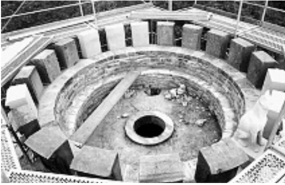
Die renovierte Plattform, noch eingerüstet, von Südwest 22.05.1996 (Foto: U. Kleine-Hering)
