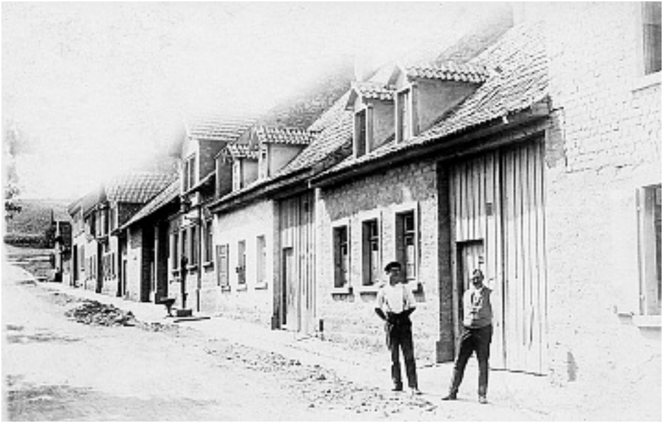
Die obere Sandgasse um 1926, zu erkennen ist der frisch verfüllte Wasserleitungsgraben (Foto: Smlg. W. Kasselmann)
