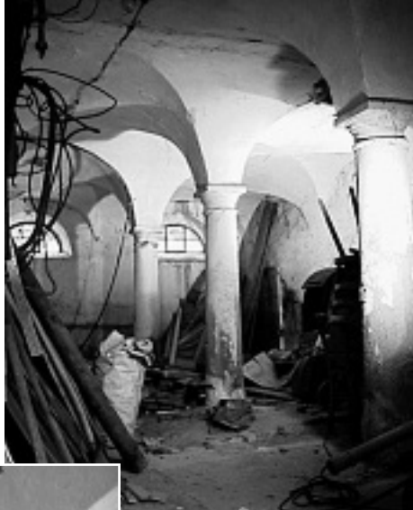
Wöllsteiner Straße (Foto: V. Hintze)
