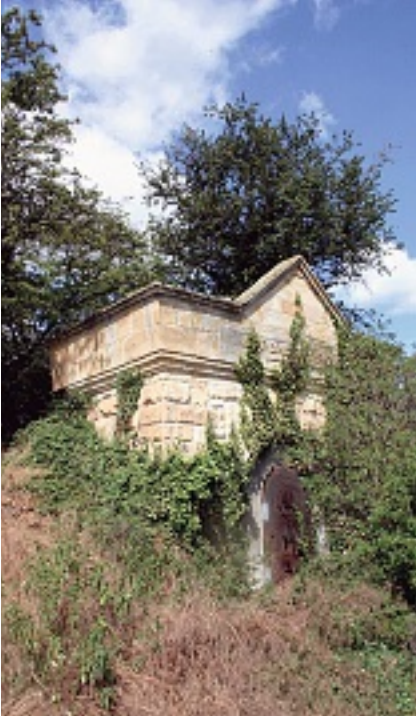
Das Wasserhaus (Foto: K. Castor)
