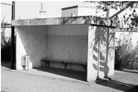
Das im allgemeinen Sprachgebrauch „Betonbunker“ genannte Buswartehäuschen (Foto: V. Hintze)
