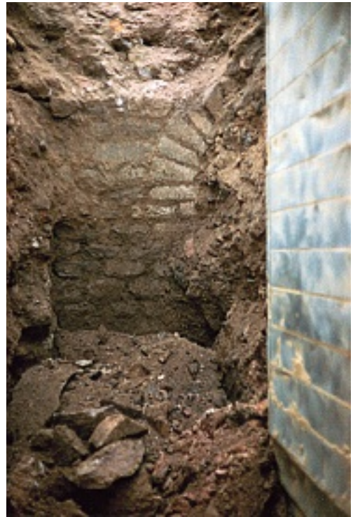
Reste der römischen Besiedlung, Kanalbauarbeiten im Römerring (Foto: K. Vetter)
